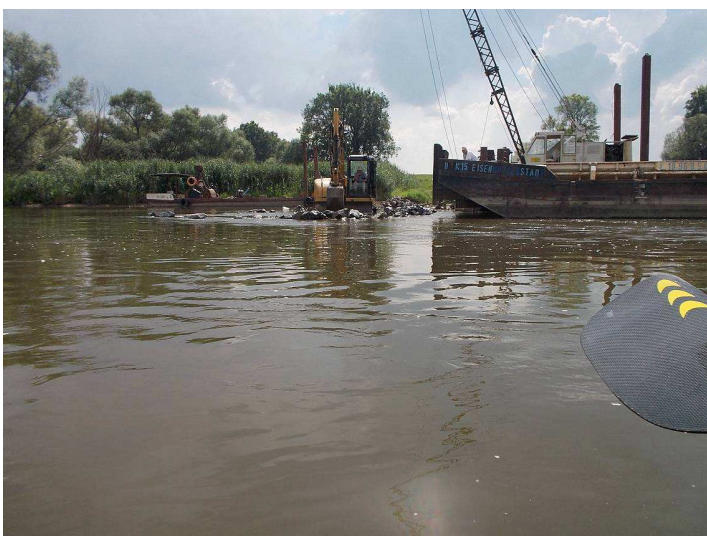
Wasserbauarbeiten an den Buhnen
