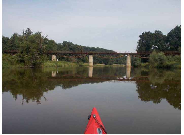
Eisenbahnbrücke - außer Betrieb
