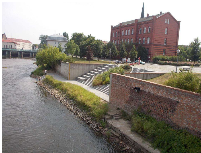
schlecht geeigneter Einstieg
