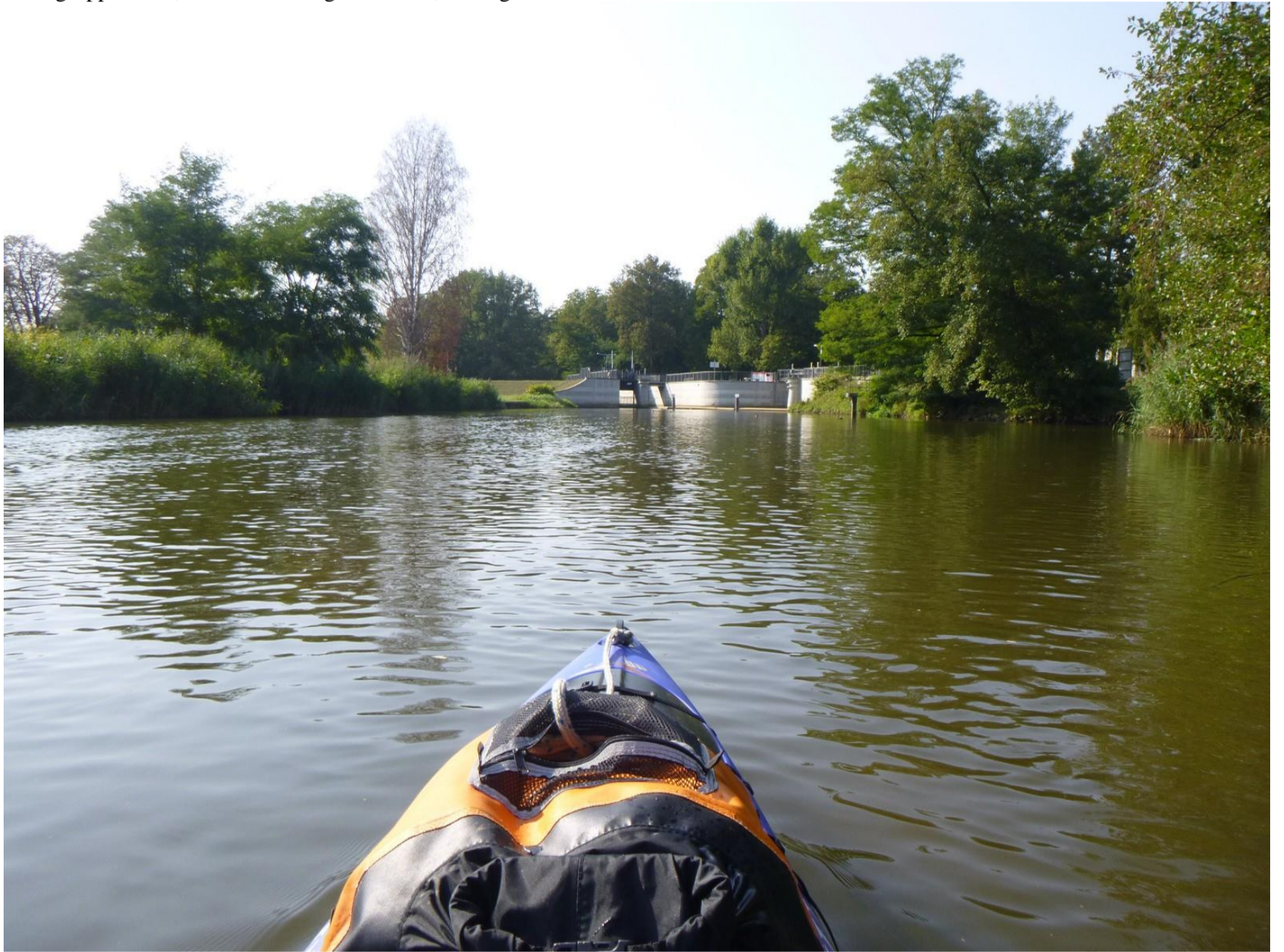
Wehrgruppe Forst, links das Mühlgrabenwehr, das eigentlich eine Schleuse ist.
