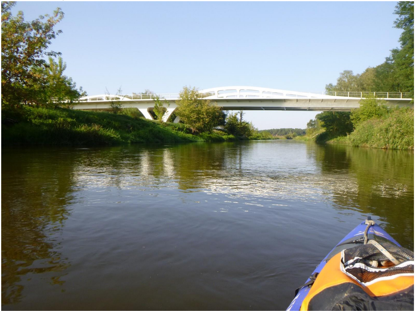
Brücke bei Coschen, hier war vor 10 Jahren eine Baustelle.
