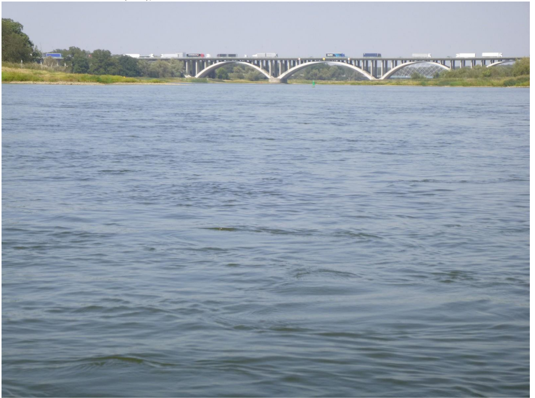
Autobahnbrücke vor Frankfurt (Oder), dahinter die Eisenbahnbrücke.
