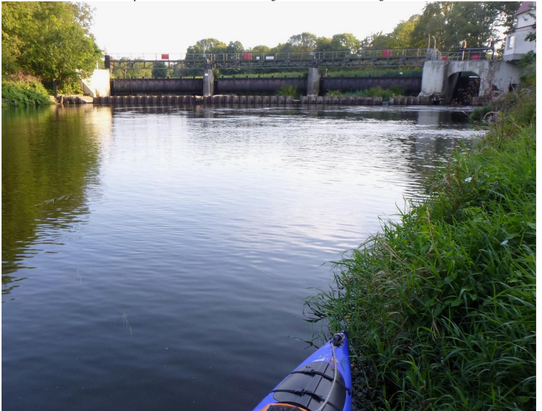
Wehr Bremenwerk. Dank der Präparation von Neiße-Tours mit erträglichem Aufwand zu umtragen.
