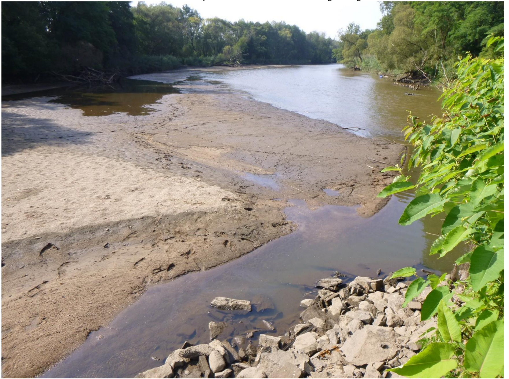
Wehr Pusack. Der Zustrom zum Wasserkraftwerk auf polnischer Seite ist fast vollständig versiegt.
