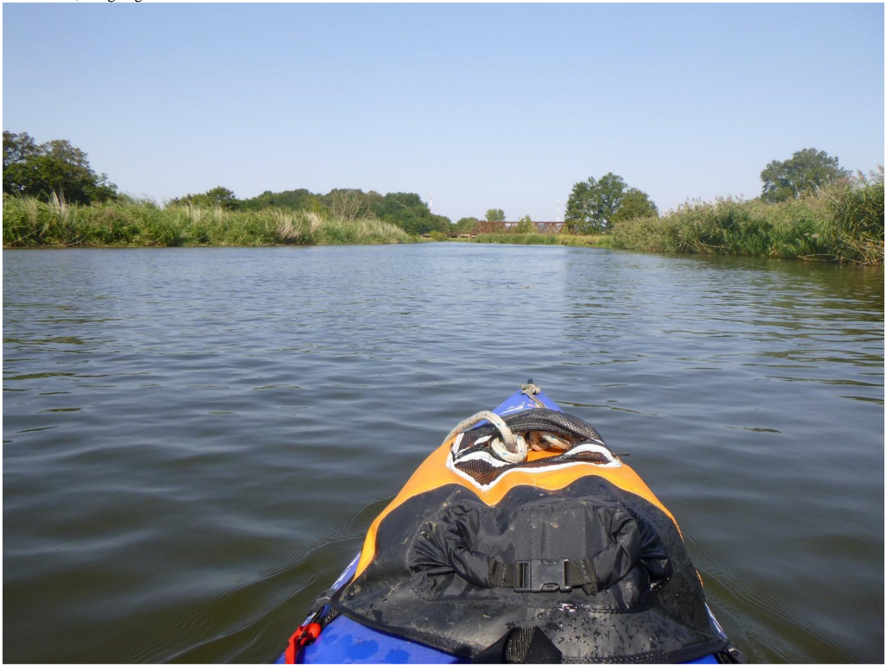
Vor Guben, stillgelegte Eisenbahnbrücke.
