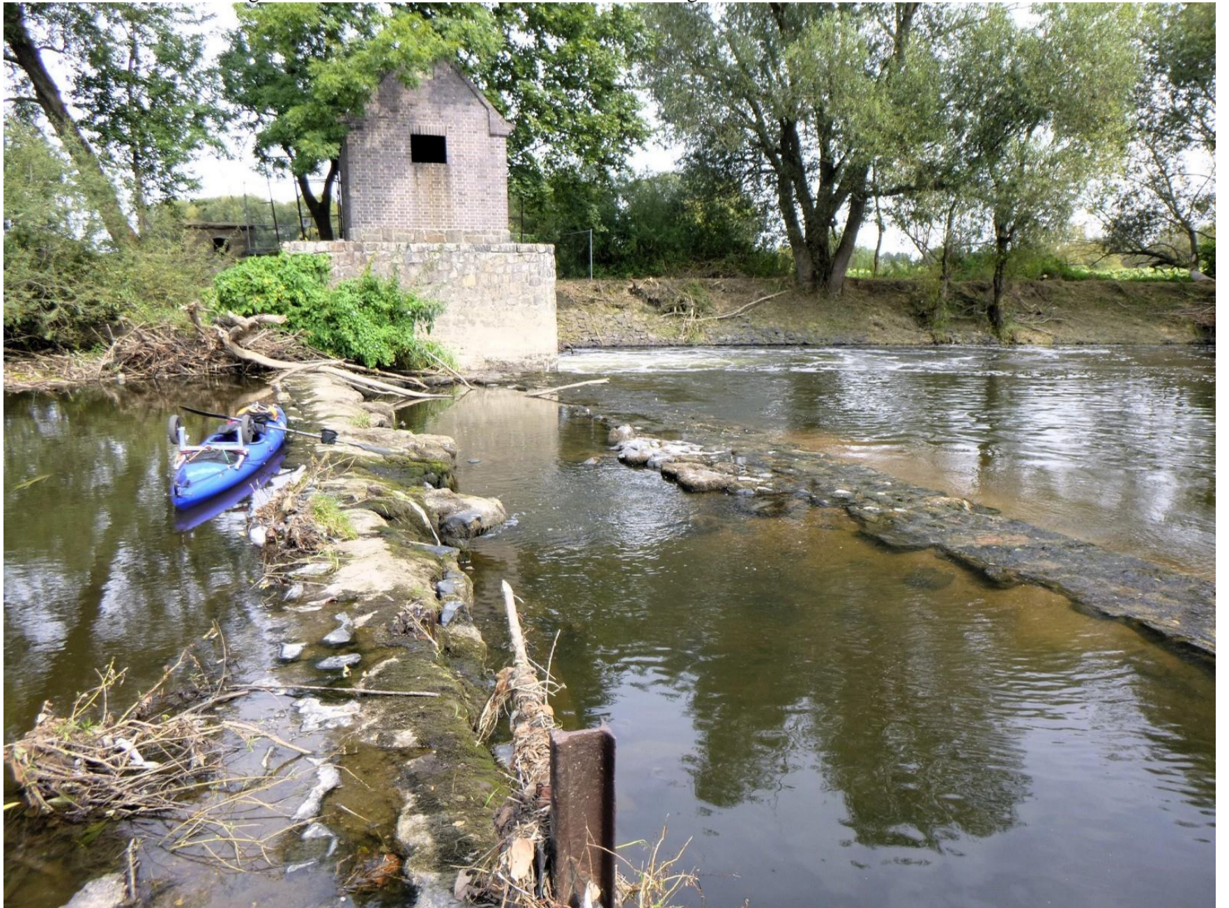
Sohlschwelle Deutsch-Ossig. Das Wasser wird durch das Wehrhäuschen umgeleitet.
