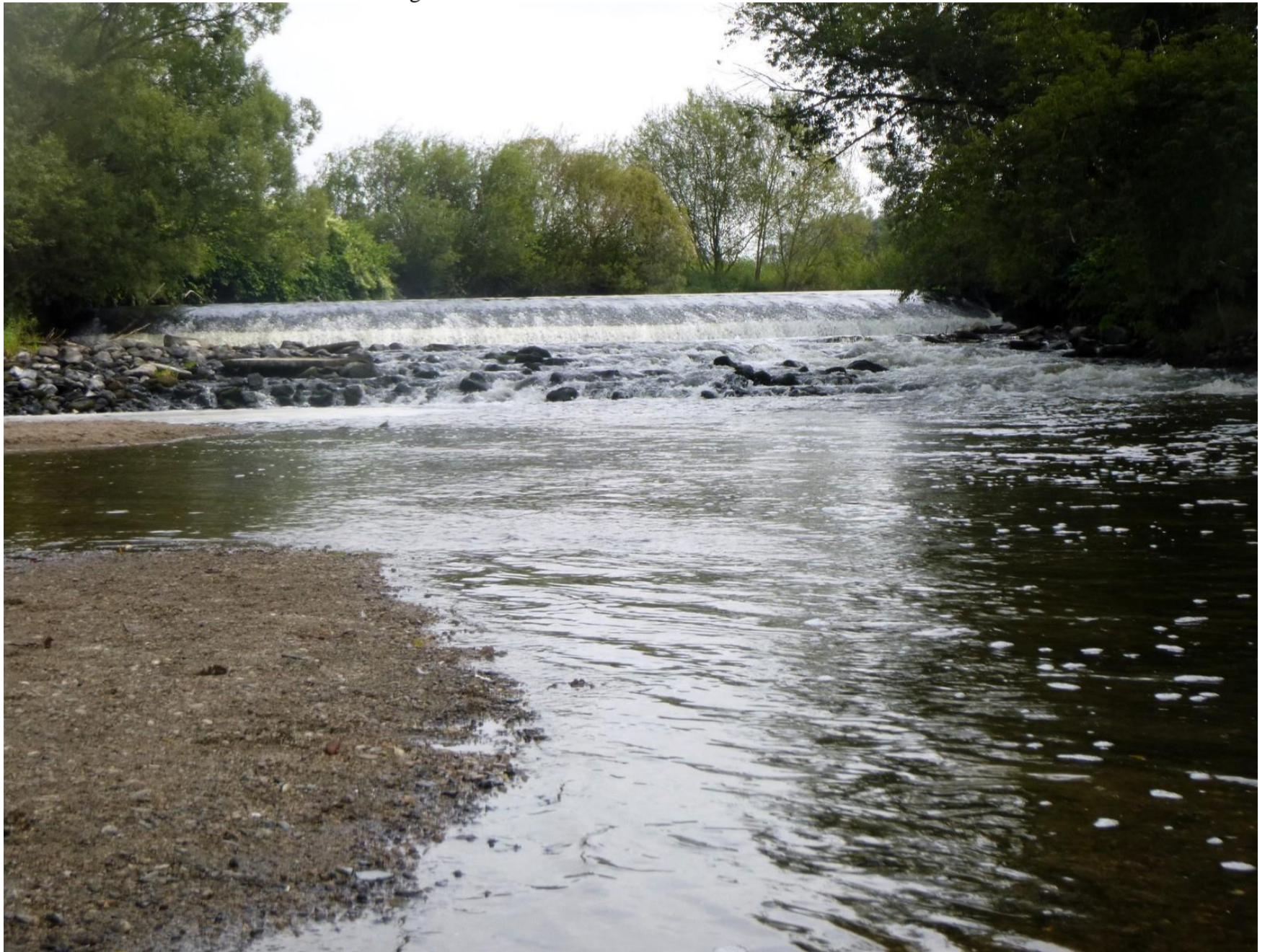
Sohlschwelle Köslitz vom Unterwasser aus gesehen.
